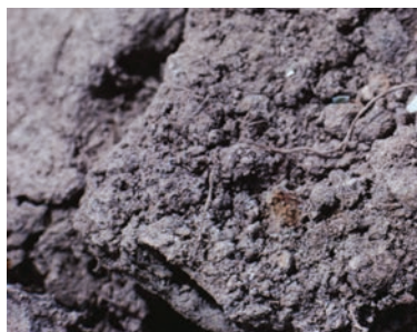
Почему необходимо проводить проверку? Агрессивный грунт.
